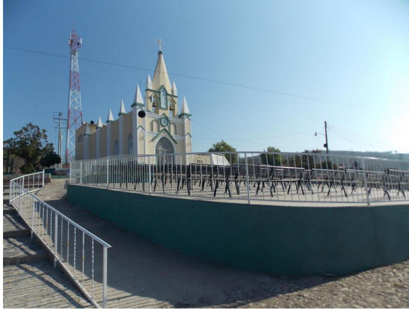
Fachada de la Capilla del Cerrito.
