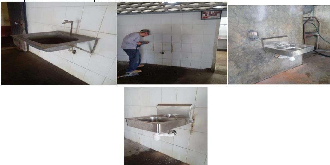
Se revisó una fuga del tinaco del rastro y se corrigió dicha fuga.
